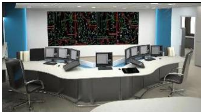
Poste de contrôle commande
